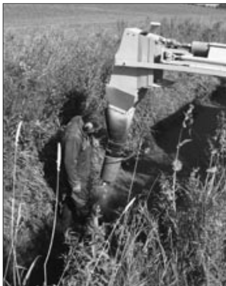
Ny teknik har indsneget sig ved udlægningen af gydegruset på en mere skånsom måde.
