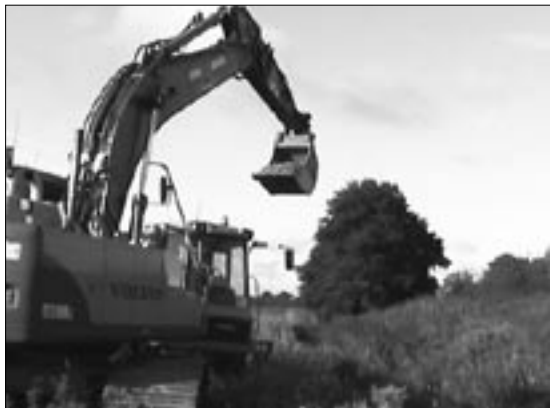
Det var store maskiner der flyttede gruset.
